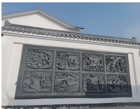
使用预制构件装饰农房外墙
