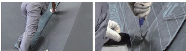
屋面防水卷材铺贴
