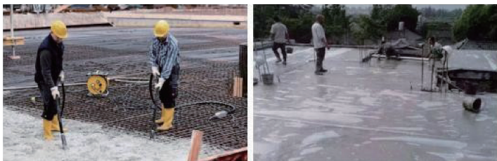
混凝土浇筑
