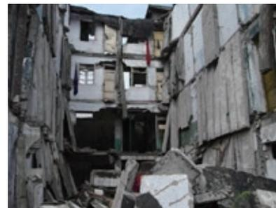
纵横墙无拉结筋震害
