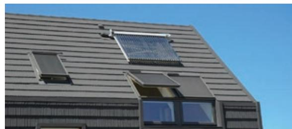
真空管型太阳能热水器
