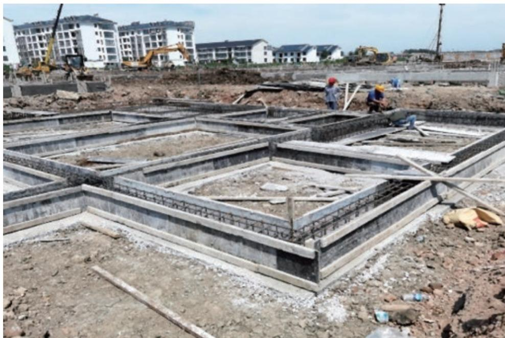
钢筋混凝土基础
