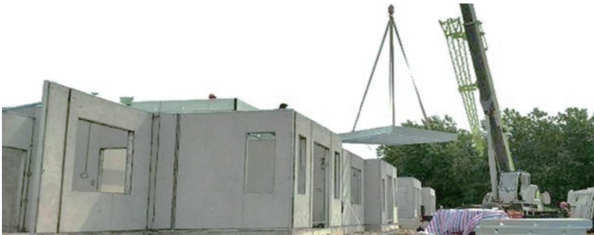
装配式混凝土墙板
