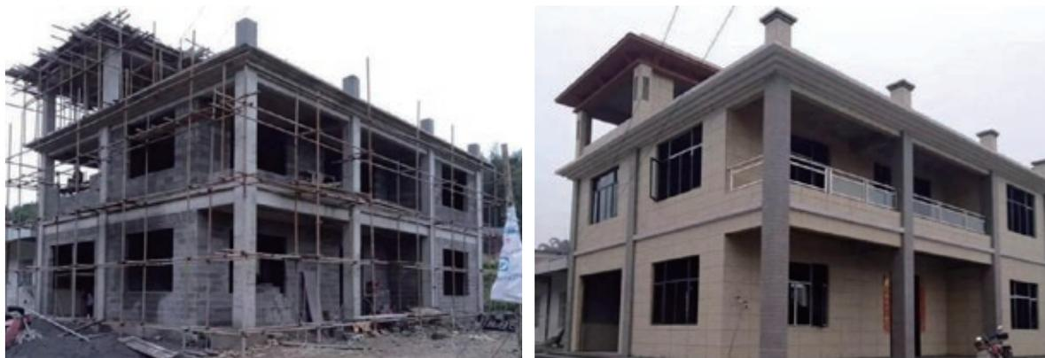
钢筋混凝土框架结构农房示意图
