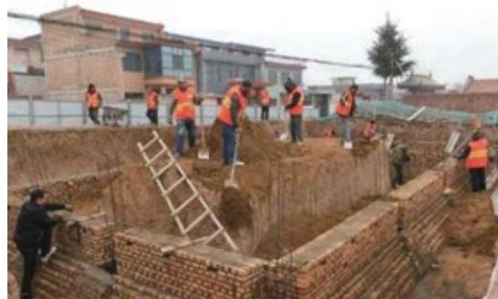
砖基础构造及施工现场
