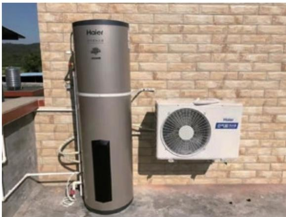
空气源热泵热水机安装示意
