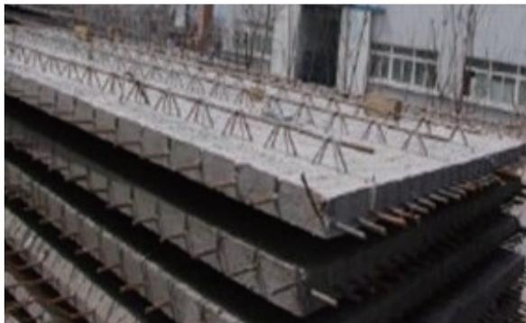
桁架钢筋叠合板
