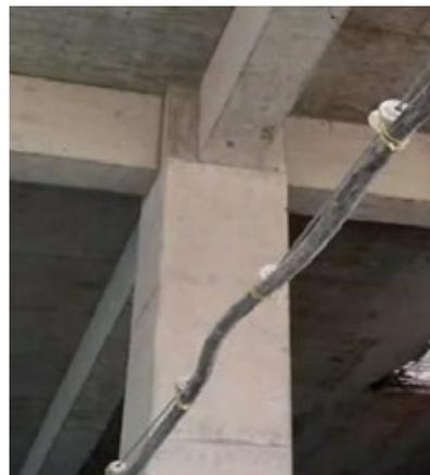
3. 施工现场使用的电缆线应绝缘良好，不得随意拖地、泡水，过道应架空或埋地套管保护，以避免机械损伤。
