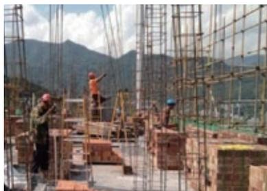
(3) 按设计规范要求留设马牙槎和拉结筋，马牙槎应先退后进，出槎60mm，每道马牙槎高度一般不超过300mm。
