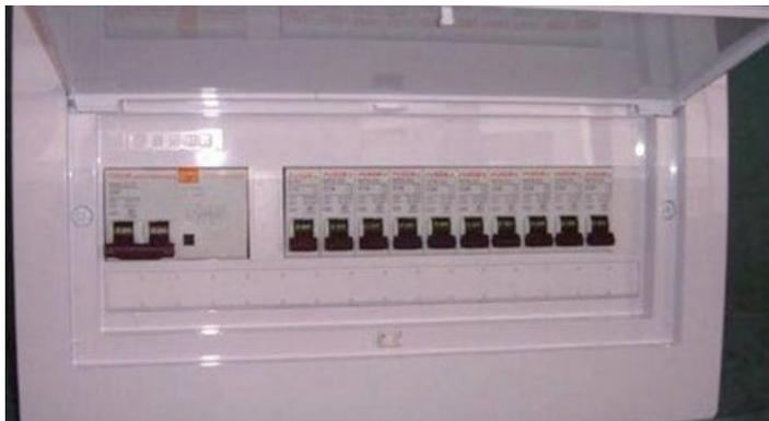
可同时断开相线和中性线的开关电器
