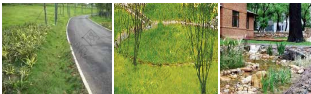
植草沟、局部下凹绿地、旱溪雨水利用示意
