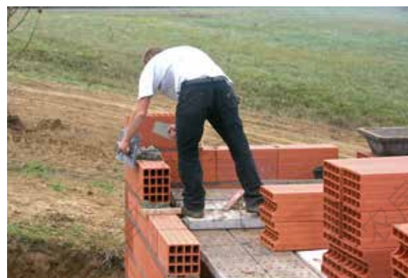
空心砌块、采用多孔砖进行墙体结构保温
