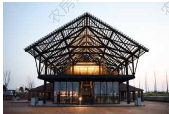
将废弃的砖窑厂改造为砖窑文化展厅、手工坊、咖啡吧等
