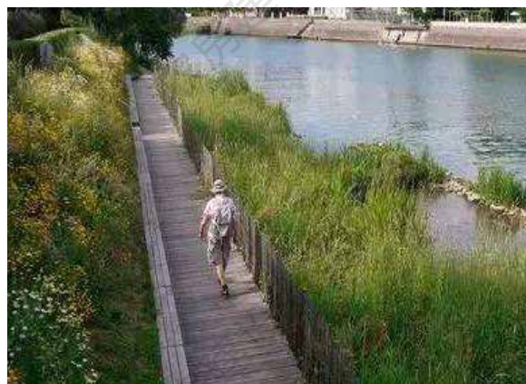
实木桩护坡，选择的实木应考虑其耐腐蚀性，实木桩不宜太高，略高于水面即可，尽量结合植物布置
