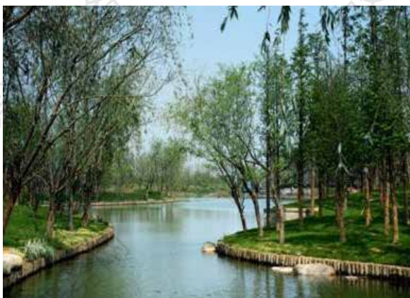
实木桩护坡，选择的实木应考虑其耐腐蚀性，实木桩不宜太高，略高于水面即可，尽量结合植物布置
