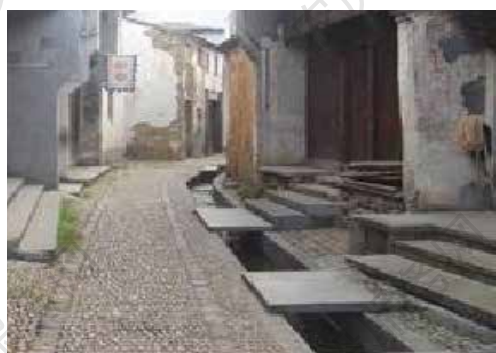
边沟与民居之间用搭板沟通
