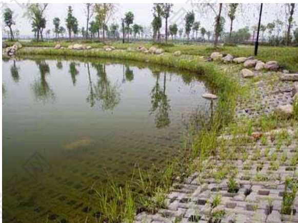
生态透水型的硬质驳岸，既能稳固驳岸，又能保持水生态，形成良好的滨水景观
