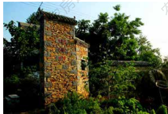
块石砌筑的景墙，乔木与灌木搭配，形成特色村口景观
