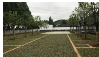
采用植草砖铺设的停车场
