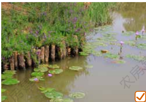
实木桩护坡，选择的实木应考虑其耐腐蚀性，实木桩不宜太高，略高于水面即可，尽量结合植物布置
