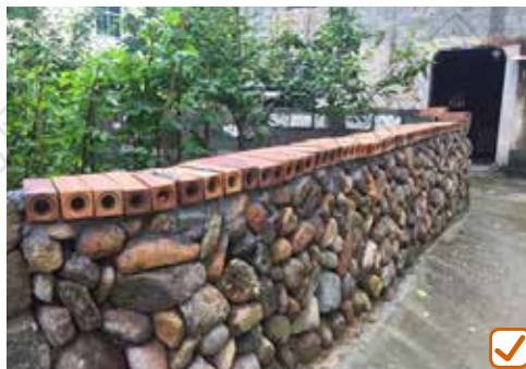
利用卵石和闲置建筑材料砌筑围墙
