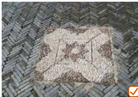
青砖及卵石结合铺装
