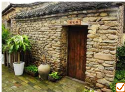
墙面采用大小各异的卵石交错垒砌，门洞口采用扁薄石板
