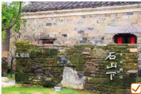
旧砖废瓦再利用：砌筑景观矮墙、铺设景观园路
