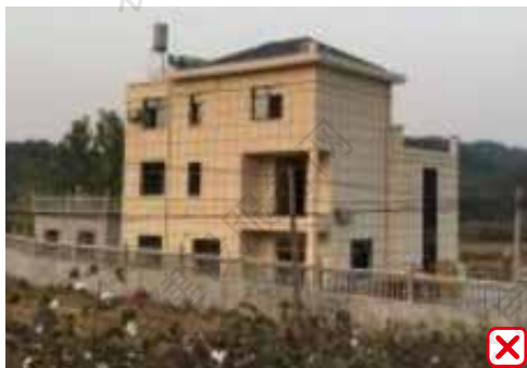
建筑体量过大
