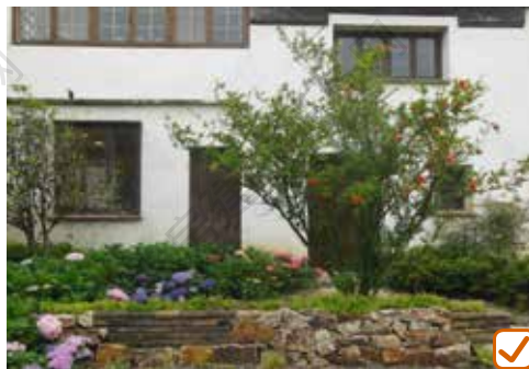
运用保温涂料的墙面
