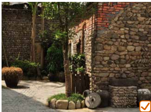
墙面采用大小各异的卵石交错垒砌，门洞口采用扁薄石板
