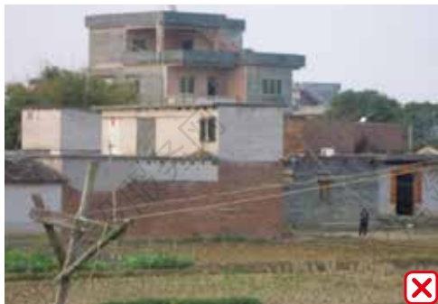
建筑体量过高，形体杂乱
