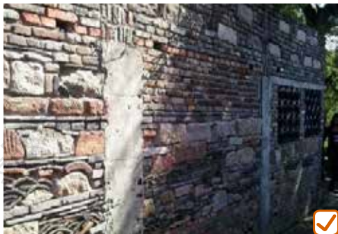
利用碎砖、废瓦砌筑农家特色围墙
