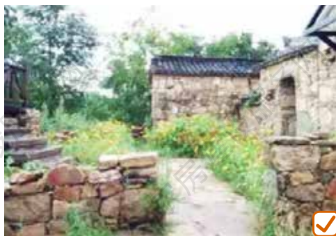
块石砌筑的围墙
