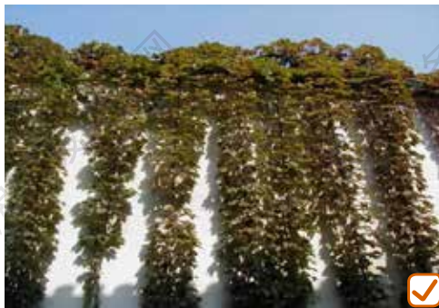
宅侧空地较小，通过爬藤植物美化山墙面
