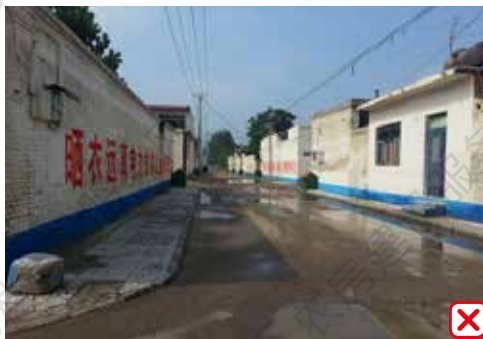
无排水设施，只考虑路面硬化，容易造成积水
