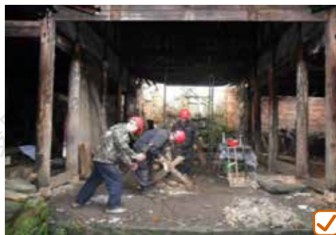
安全性整治，对隐患部件进行加固处理
