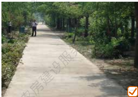
采用水泥路面的村庄内部主要道路
