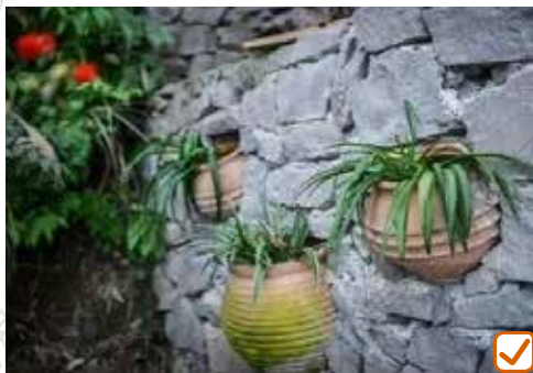
利用坛子、绿植和水泥块石共同砌筑特色围墙
