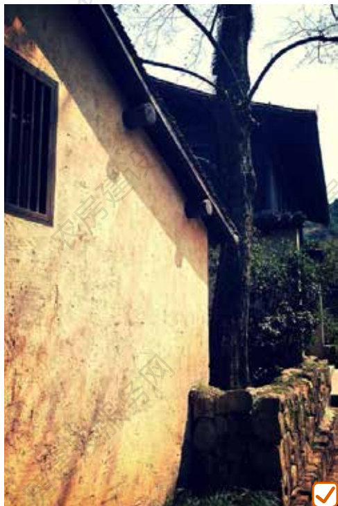
屋面挑檐对夯土墙的保护，避免雨水冲刷
