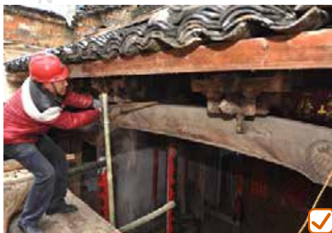
安全性整治，对隐患部件进行加固处理
