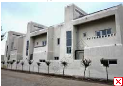
建筑连续界面过长，过于生硬
