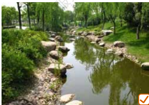
抛石护坡, 宜适用于有块石资源的地区, 应与绿化植被相结合
